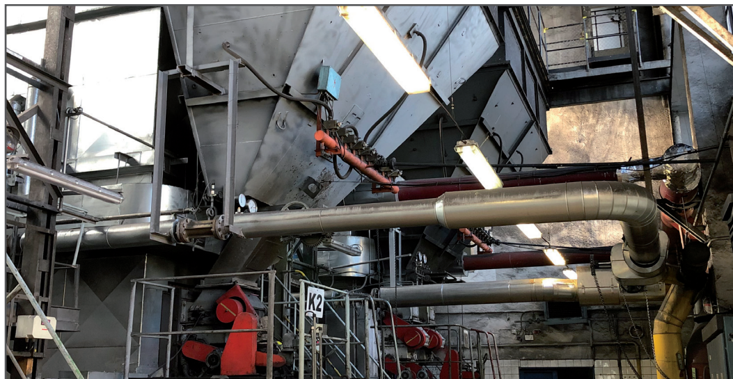
Kotle K2 a K3, ve kterých teplárna v letním a přechodném období využívá jako palivo biomasu.
