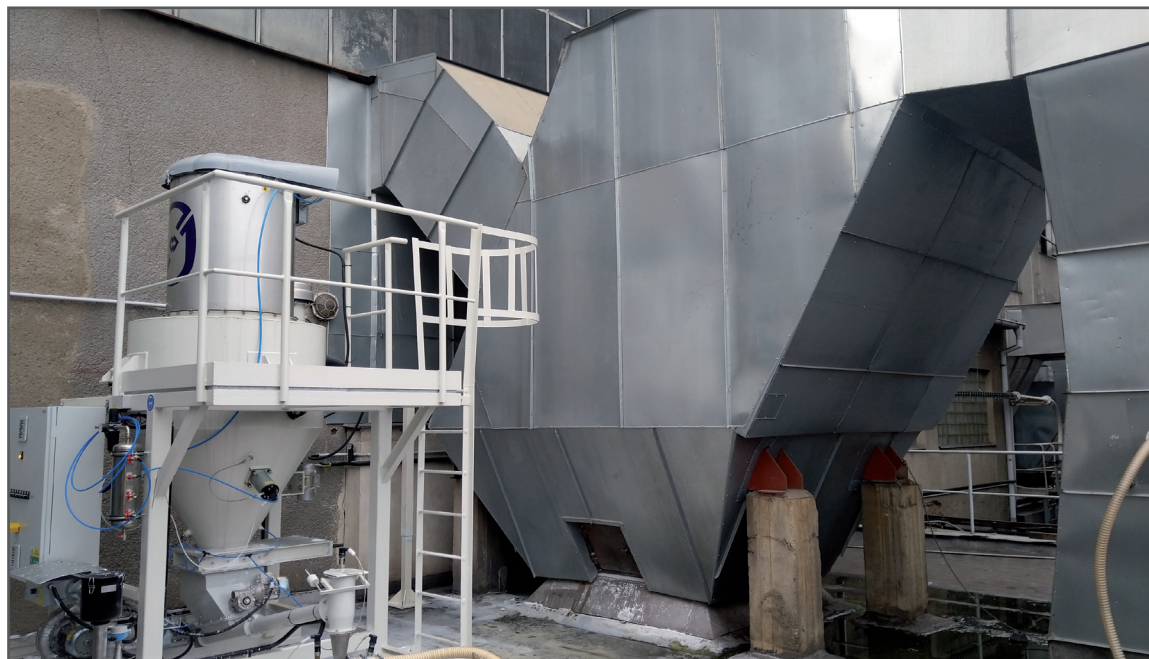
Nové zařízení na vstřikování vápenného sorbentu přímo do spalin snížilo emise z teplárny.
